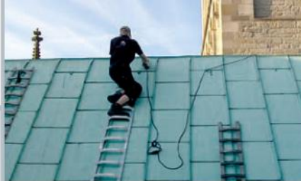
Arbeiten auf der Baustelle...
